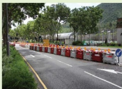
文東路(足球場)的臨時交通管理 Temporary traffic management on Man Tung Road (near football field)
