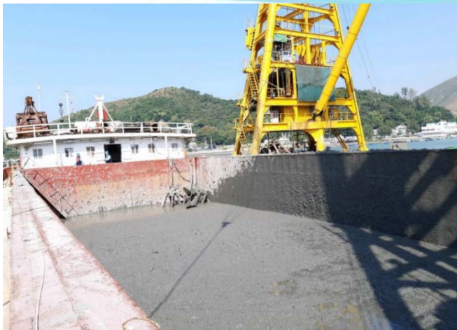
大澳疏浚工程掘出海泥
